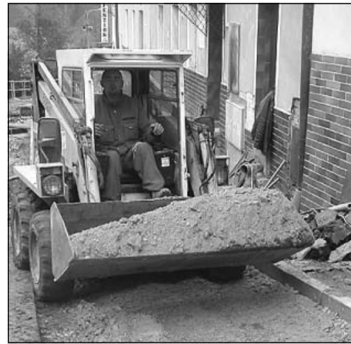
Výměna vodovodu a kanalizace v Rožmberské ulici je hotová. Foto Libor Pils
